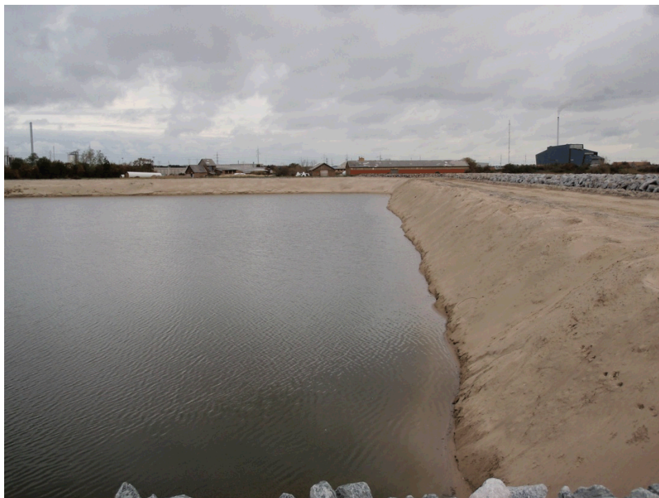
Figur 5.7: Indre digeskråninger mod brakvandsområdet (øverst i billedet) og Vadehavet (til højre i billedet) (Foto: NIRAS, 2015).
