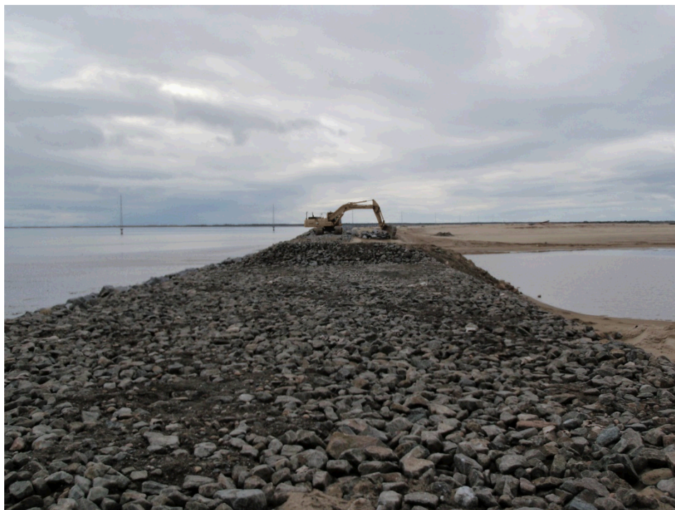
Figur 7.19: Diget rundt om Esbjerg Sydhavn er ved at blive etableret i efteråret 2015. (Foto: NIRAS, 2015).
