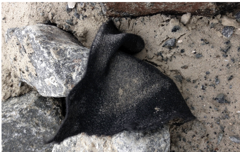
Figur 5.12: Der er udlagt filterdug under stenene på den dæmning, der er etableret mellem projektområdet og de nærliggende vandområder (Foto: NIRAS).
