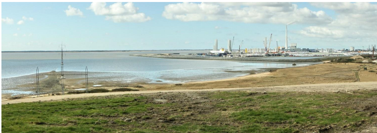
Etape 5 havneudvidelsen er planlagt til at blive placeret mellem elmasterne til Fanø og etape 4 havneudvidelsen. Foto: Claus Nissen, april 2021.
